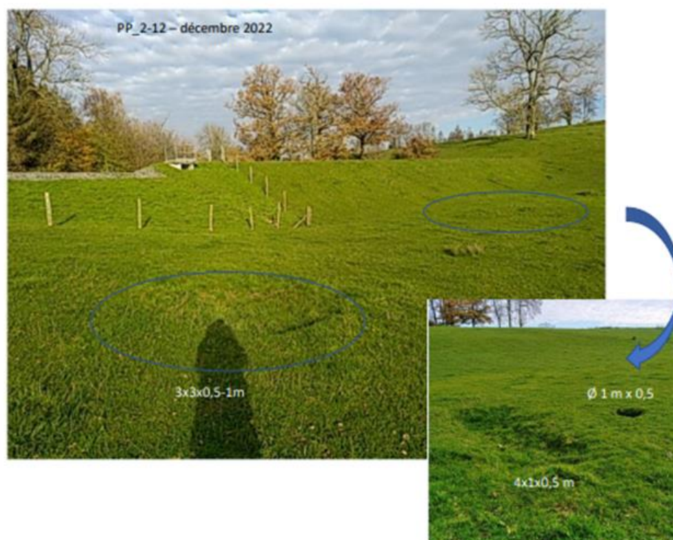
Figure 75 : Exemple d'apparition de bétoires dans l'emprise d'un bassin de rétention du SMBVAS
