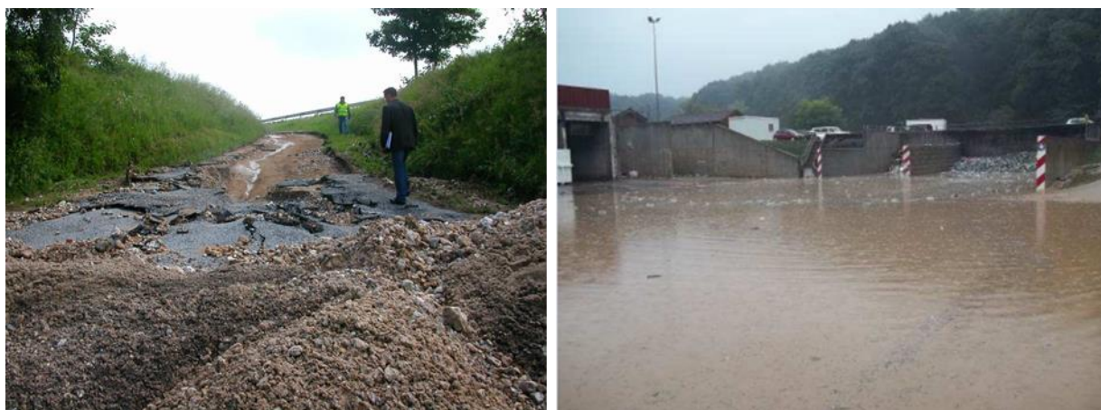
Figure 32 : Exemples de dégâts lors de ruissellements pour des évènements pourtant non identifiés comme majeurs – Dégât sur voirie à Malaunay 10 juin 2010 (à gauche) et inondations de la zone de stockage des déchets ménagers à Maromme le 13 août 2015 (à droite)
